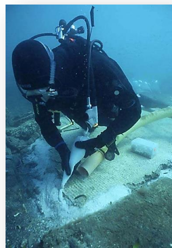
Figura 2. Baia (Napoli). Villa con ingresso a protiro. Iniezione della malta con l'ausilio di sacche in tela idrorepellente
